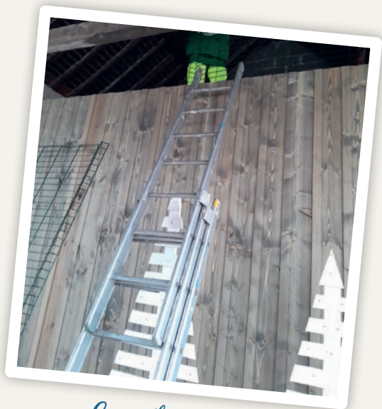
Cour élémentaire Sécurisation sanitaire
