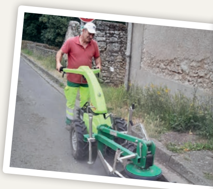
Décapage au bord des routes avant intervention Réparoute
