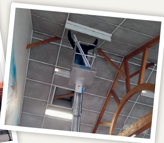
Salle des fêtes Remplacement néons LED
